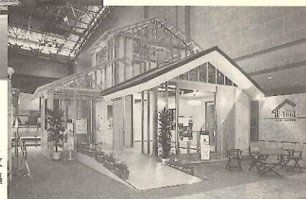
同ショーに展示された改良型のスチールハウス躯体モデル
