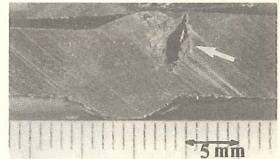
溶接金属部断面での腐食孔
