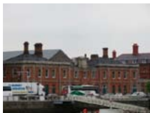
図 2-5 煉瓦造りの建造物
