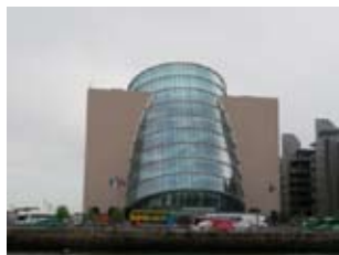
図 2-1 コンベンションセンター
